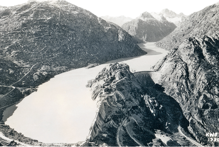
Grimsel Hospiz mit Grimselsee, Seeufereggsperrre und Spitallamm-Staumauer im Jahre 1930
