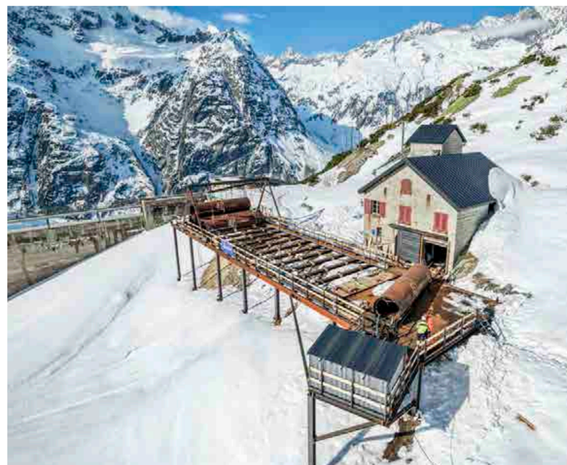
Der Beginn des Druckschachts Handeck verbirgt sich hinter dem «Garagentor» des Wärterhauses am Gelmersee ganz rechts.
